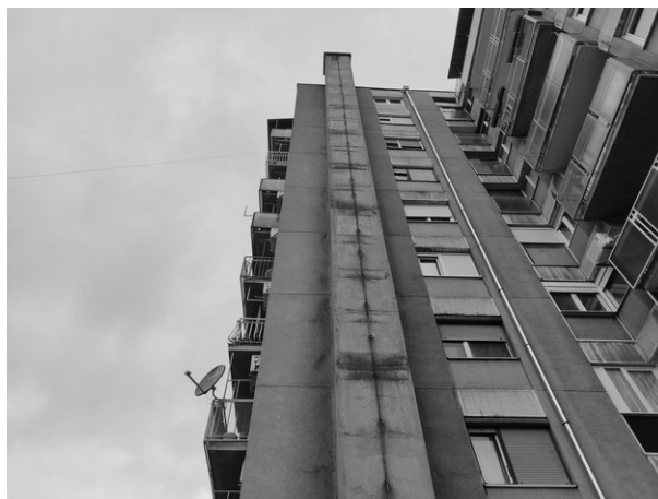
Slika 3. Izgled emitera kotla 1
