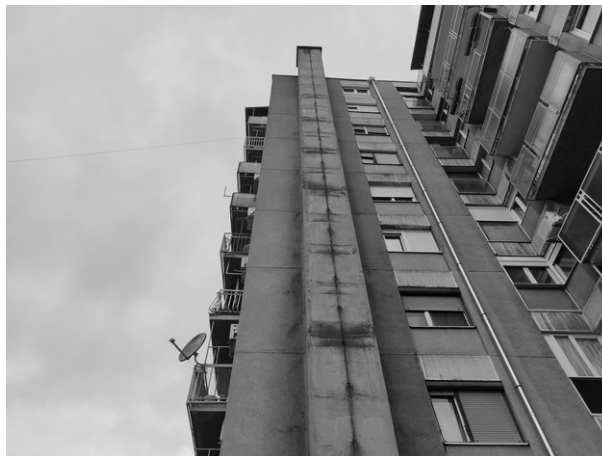
Slika 5. Izgled emitera kotla 2
