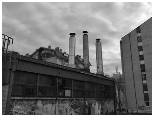
Slika 3. Izgled emitera kotla 1
