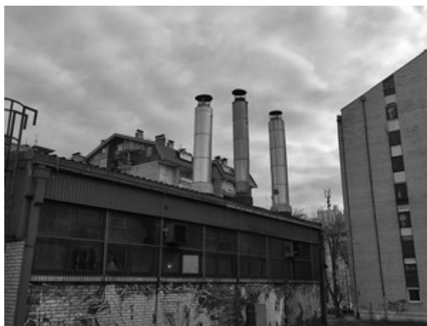
Slika 5. Izgled emitera kotla 2
